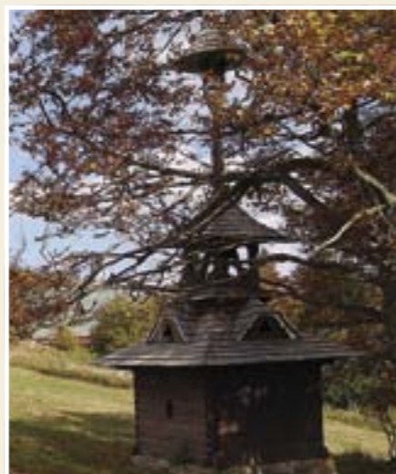
Pustevny - zvonice. Foto: Archiv ZK - Pavel Kosek
